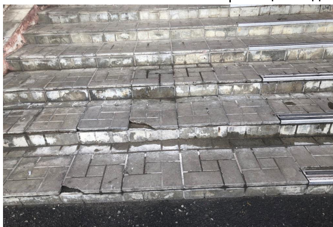
9) 05.09.23 Установка отпавших и сломанных плиток на крыльце входной группы
