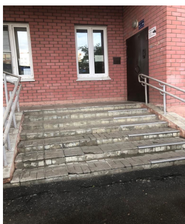
9) 05.09.23 Установка отпавших и сломанных плиток на крыльце входной группы
